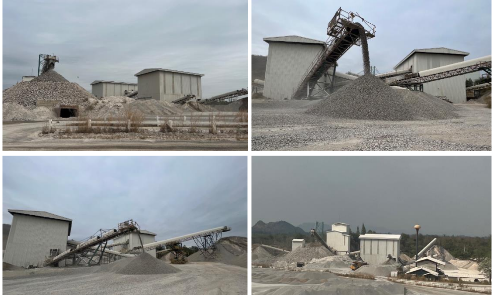
ภาพประกอบโรงโม่หินก่อสร้าง
